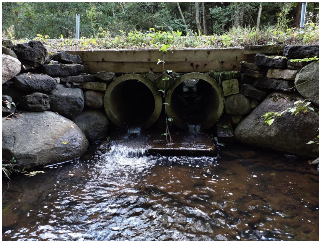
Joonis 3. Oju jõel asuva Läägi truubi väljavool.
