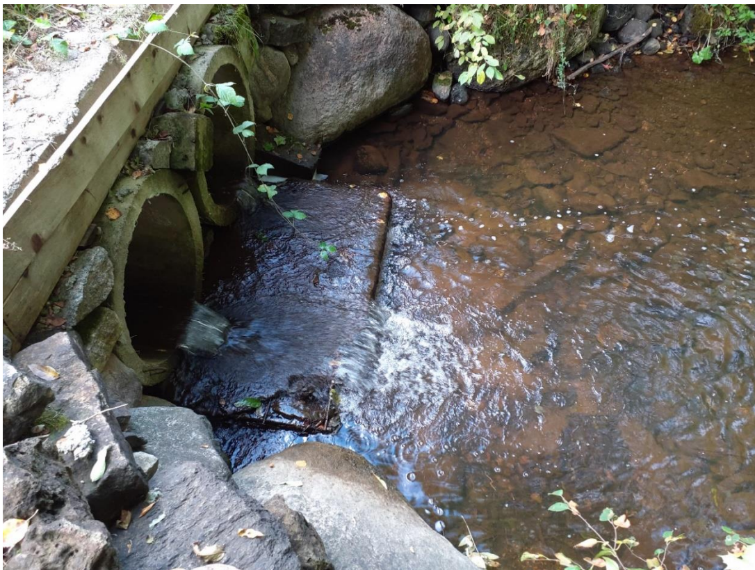
Joonis 4. Läägi trubi esine betoonastang.
